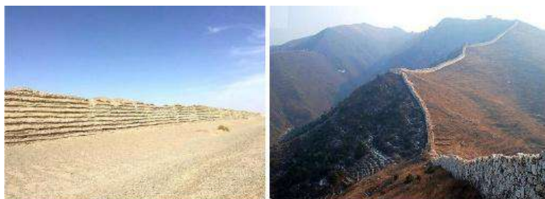
სურ.24. ჩინეთის დიდი კედლის ფრაგმენტები, აგებულია (a) დატკეპნილი თიხისგან და (b) ქვისგან 59
